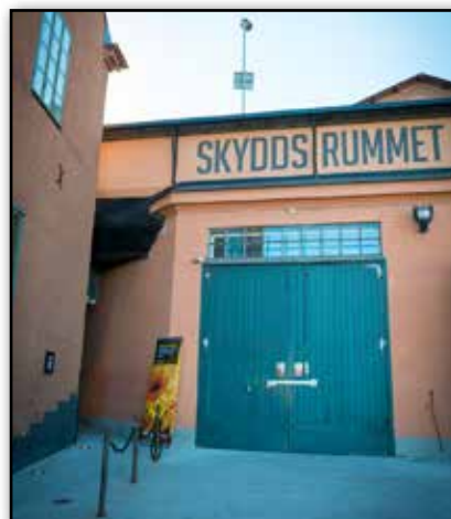
VA-dagen ägde rum i ett före detta skyddsrum i centrala Stockholm.
